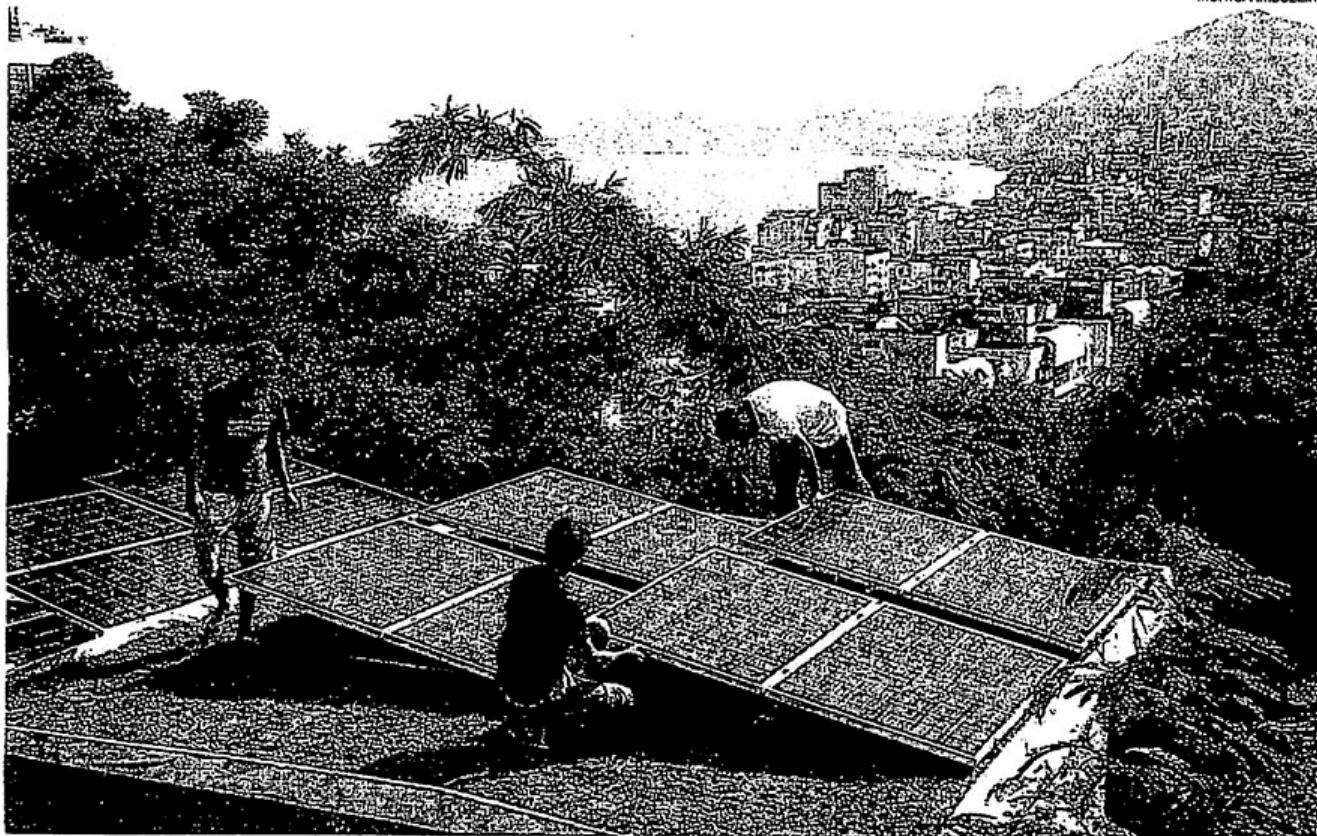
Energia limpa. Painéis fotovoltaicos são instalados no telhado de hostel, no Morro da Babilônia: moradores ajudam a montar as placas
